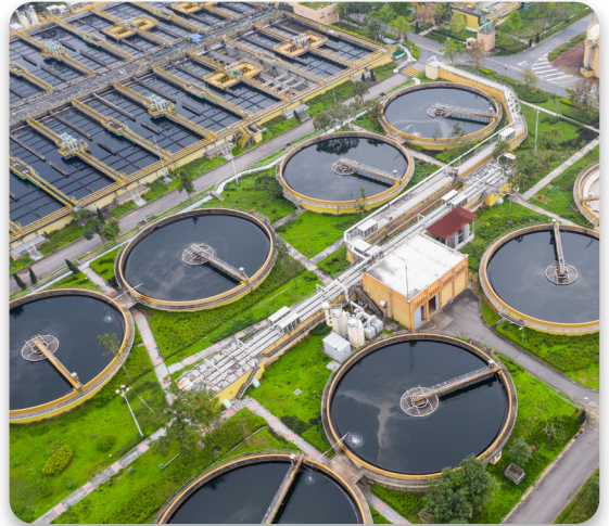
Görsel 6.17. Atık Su Arıtma Tesisi
